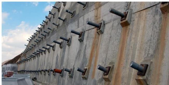
**Ilustración 2 – Anclajes con cabezal**
