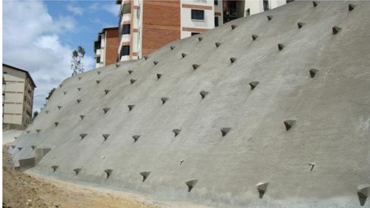
**Ilustración 10 – Muro de Contención Anclado**
