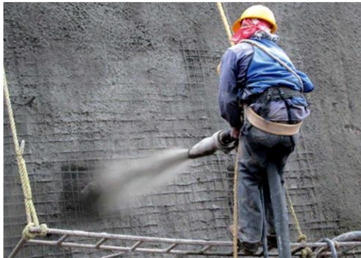
**Ilustración 6 – Lanzado de Concreto en Pantalla**
