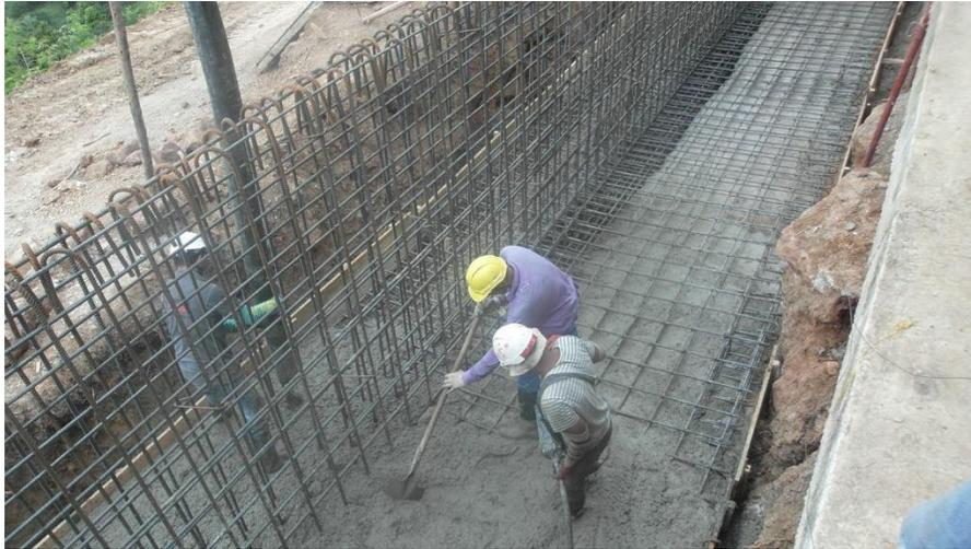
**Ilustración 9 – Armado de Acero Muro de Contención**
