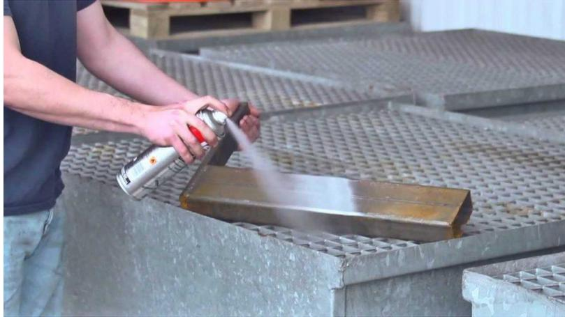
**Ilustración 3 - Recubrimiento contra corrosión**
