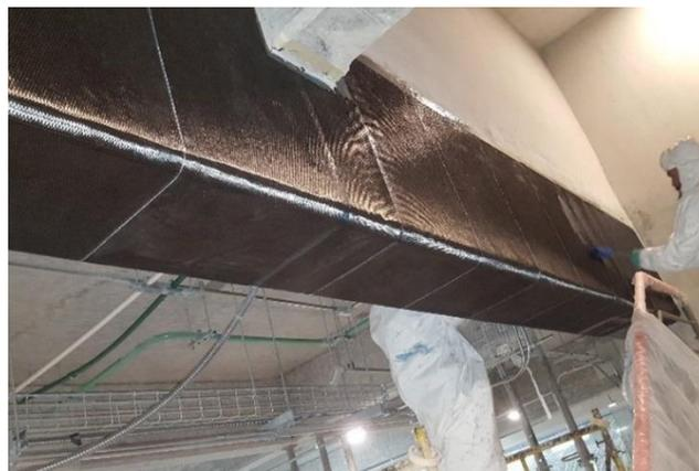
**Ilustración 5 - Refuerzo de Fibra de Carbono Externo**
