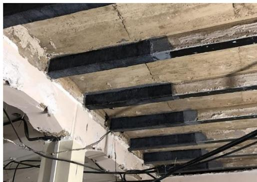
**Ilustración 4 - Refuerzo de Fibra de Carbono**
