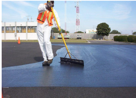
Ilustración 25. Impermeabilización de suelo con asfalto
