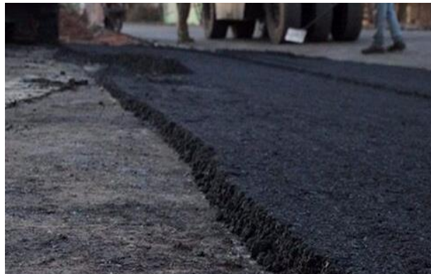
Ilustración 28. Concreto asfáltico recién colocado
