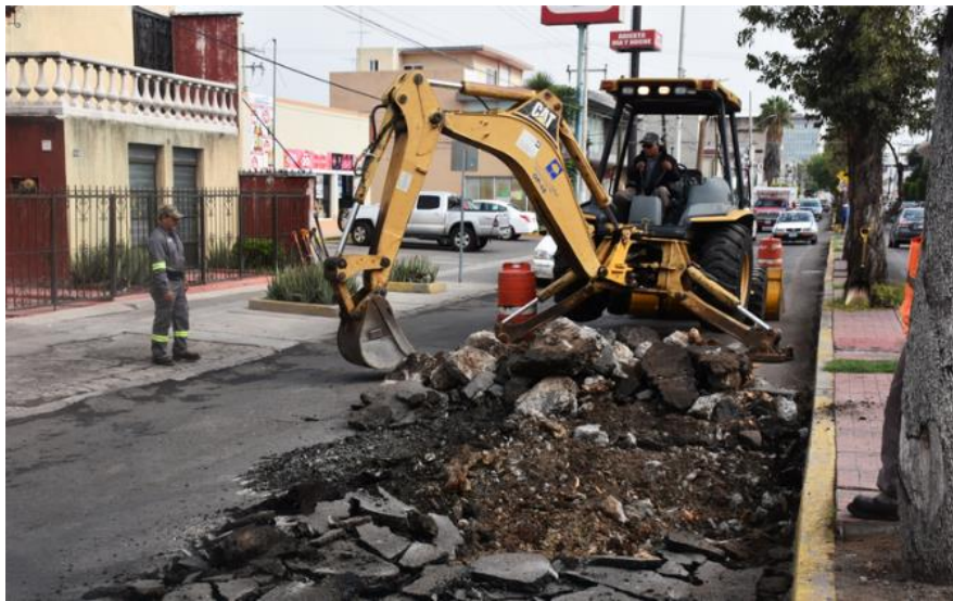
Ilustración 1. Demolición de carpeta de concreto asfáltico
