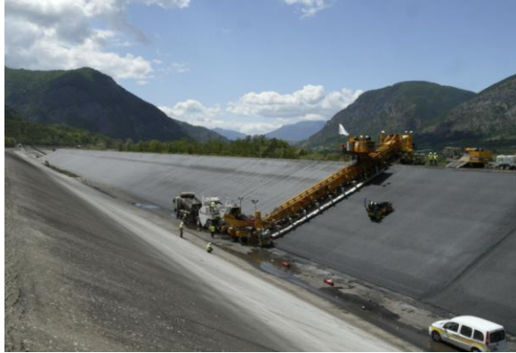
Ilustración 26. Revestimiento con asfalto de canal abierto
