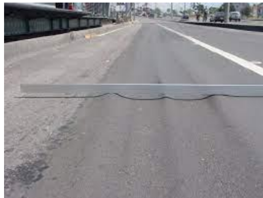
Ilustración 13. Roderas o canalizaciones
