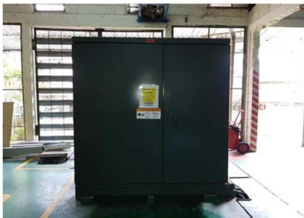
**Ilustración 10. Transformador Tipo Pedestal**
