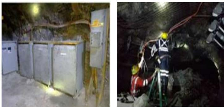
Ilustración 19: Instalación de subestación de 300 KVA nueva subestación en L-2500 Canoe.
