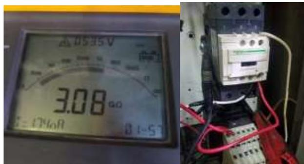
Ilustración 27: Prueba de aislamiento a equipos.
