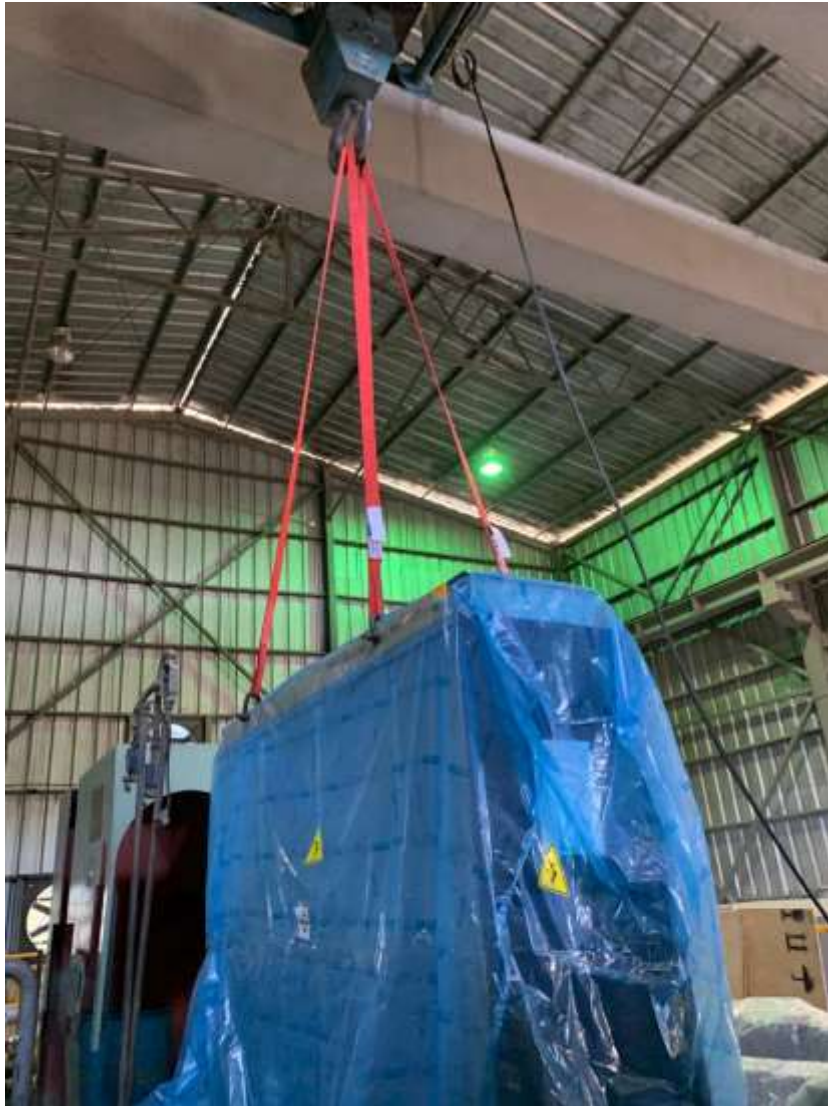
Ilustración 35. Variador del generador GEVISA con eslingas.
