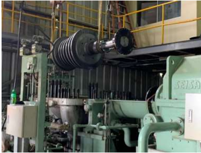
Ilustración 15. colocación de turbina del generador
