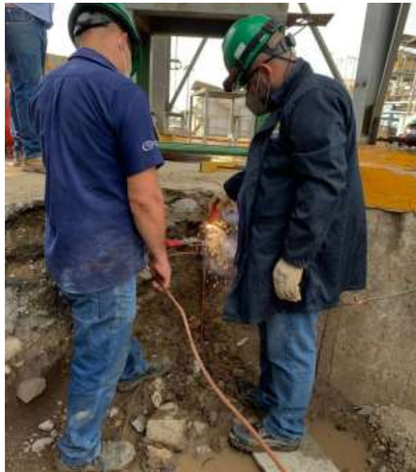
Ilustración 18. Soldadura de malla a tierra
