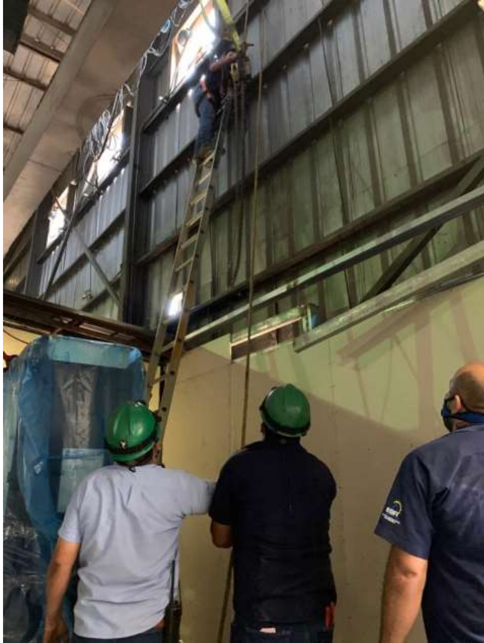
Ilustración 36. instalación de variado del generador GEVISA.
