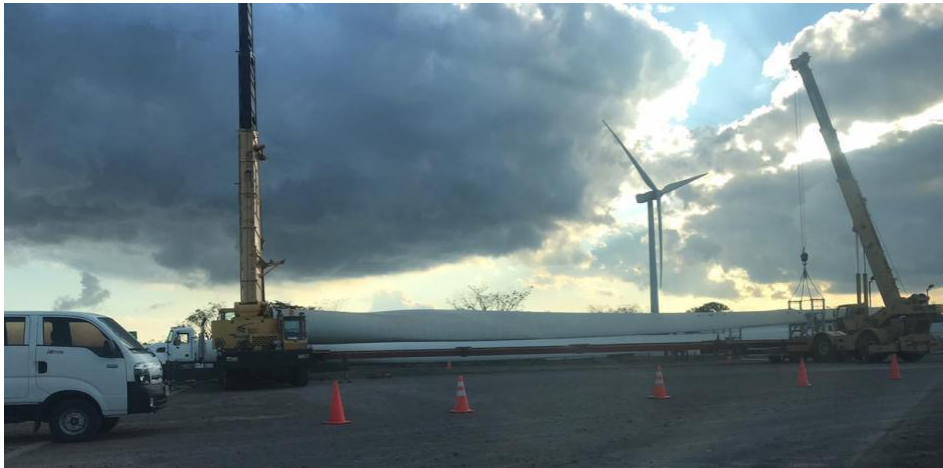
Ilustración 5. Descarga de pala nueva.
